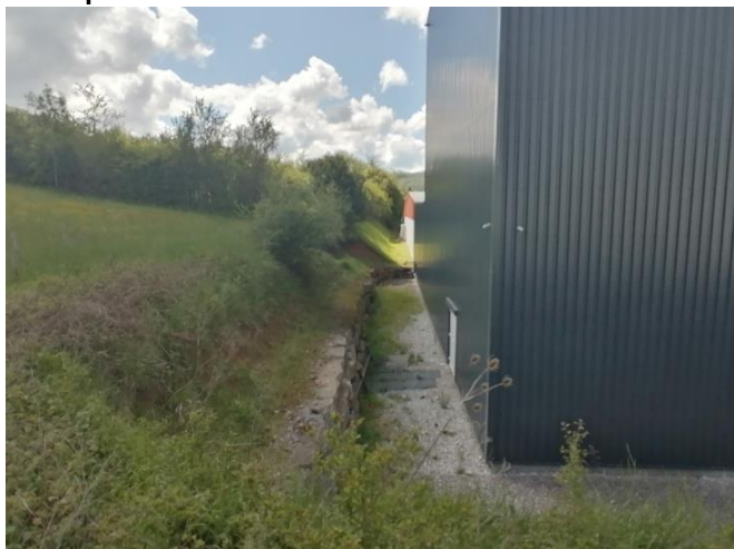
Vue depuis l'arrière du bâtiment d'escalade
